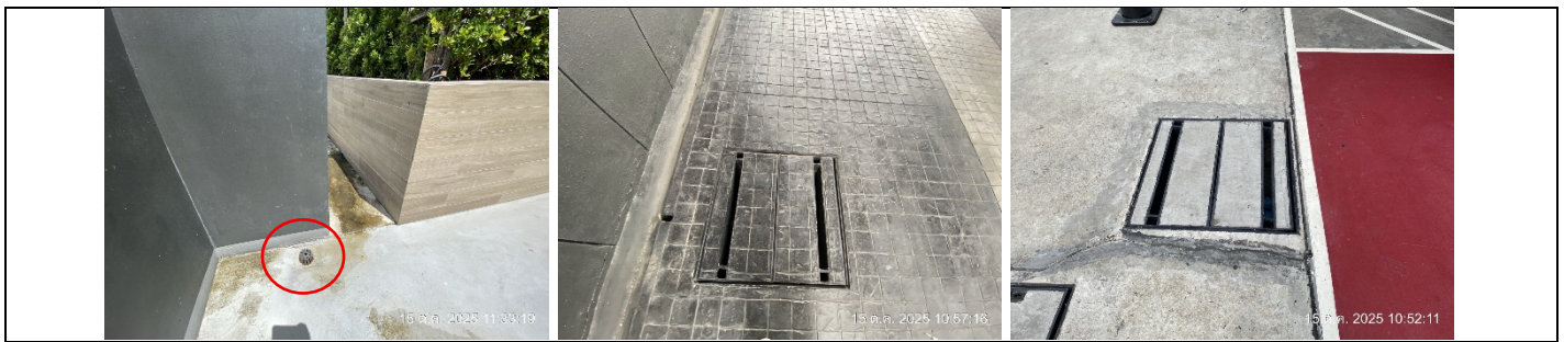
รูปที่ ผ7.52 ตะแกรงครอบตามรูปท่อ และท่อระบายน้ำทั้งภายในและภายนอกอาคาร
